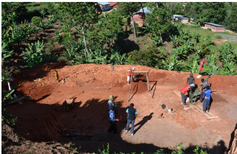
Die Baustelle von oben. Rechts ausserhalb des Bildes liegt die Secondary School. Die Gebaeude unterhalb gehoeren zur Grundschule.
